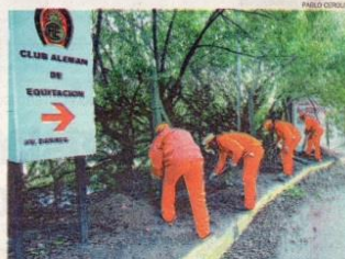
ABRIENDO ESPACIO. LA PISTA, DE USO PÚBLICO, ERA DE MUY DIFÍCIL ACCESO.
