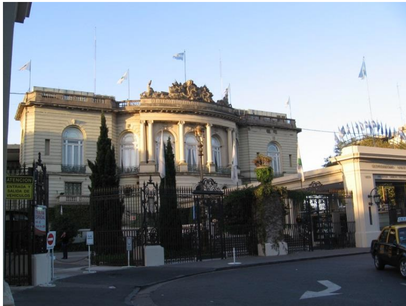
Sector principal sobre Av del Libertador.
