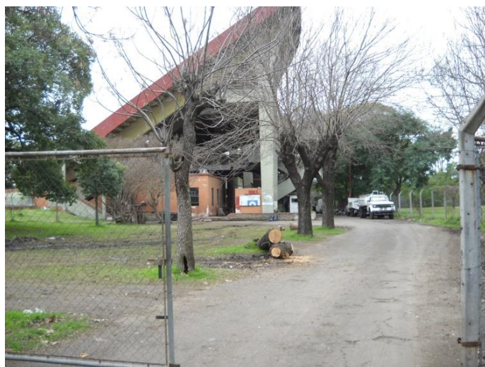
2010 septiembre 05. Acceso al sector ocupado por Mantelectric / Parquizar.
