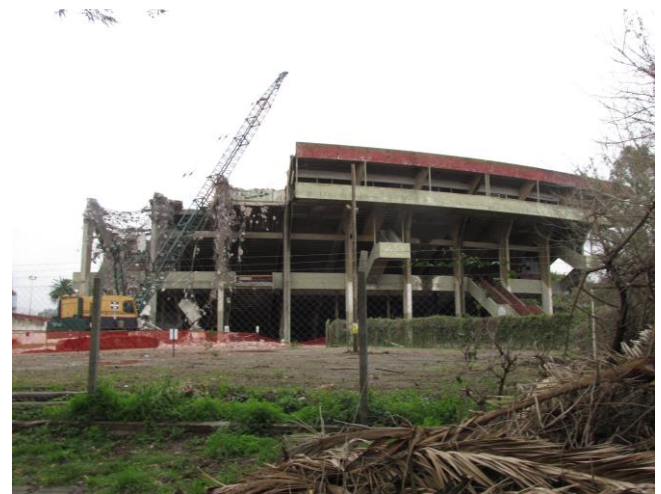
2015 agosto 08. Demolición tribunas.
