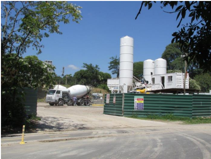
2018 enero 15. Planta productora de hormigón, instalada provisoriamente en el predio, destinada a la elaboración de piezas premoldeadas para la construcción del cercano viaducto ferroviario.
