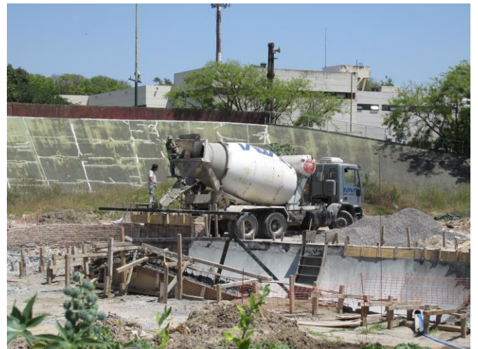
2016 diciembre 17. Hormigonado de la hoya central destinado a skate.
