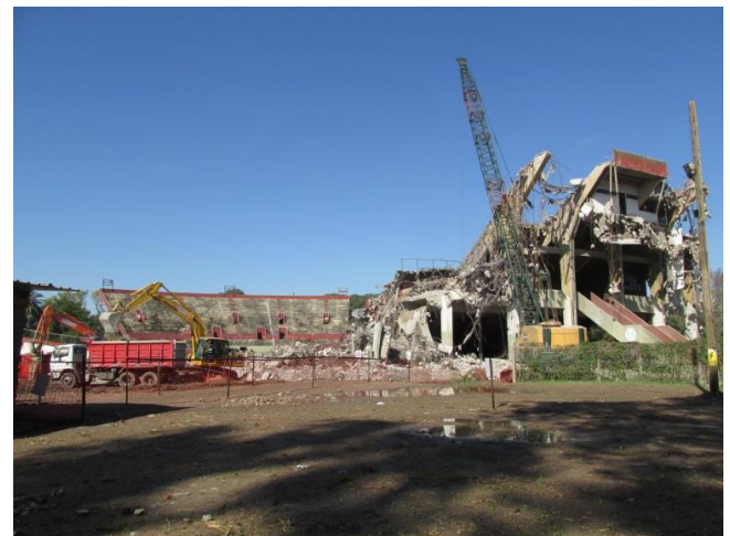
2015 agosto 15. Tribunas en demolición
