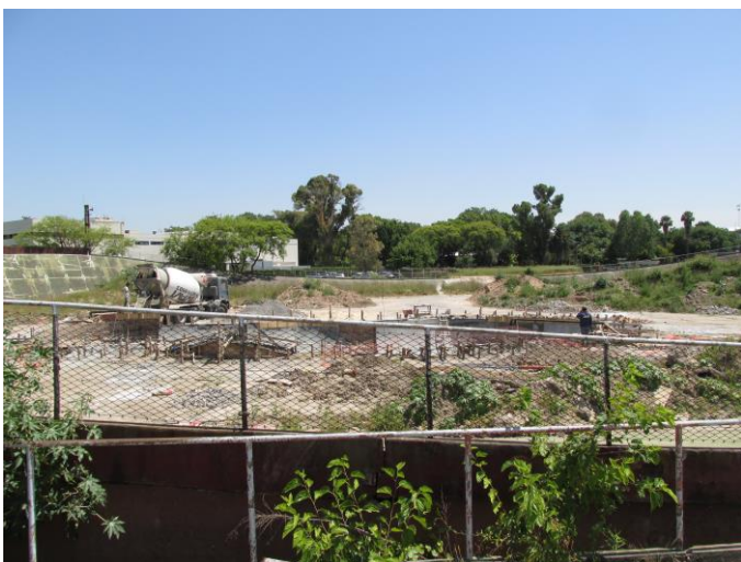
2016 diciembre 17. Obras sobre el centro de la pista.
