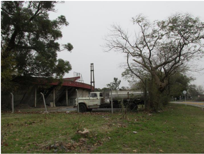
2015 julio 12. Zona ocupada por Mantelectric / Parquizar, alejadas del área de influencia de la demolición que deberían ser espacio verde público desde hacía más de un año.
