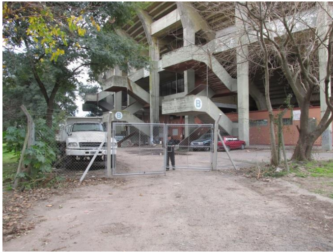
2014 julio 21. Base de operaciones de Mantelectric / Parquizar.
