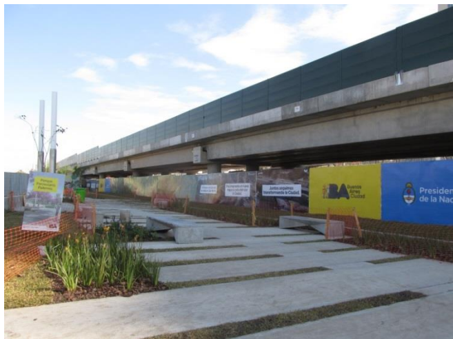
Parque Ferroviario Palermo. Sector junto al nuevo viaducto.
