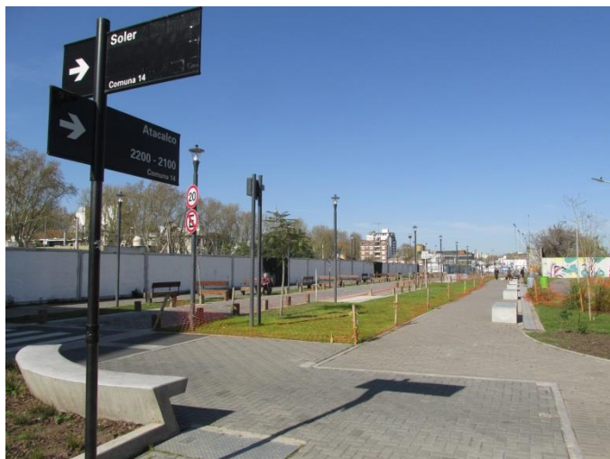
Apertura de nueva calle paralela a Godoy Cruz con salida a Soler. A la izquierda, cerco de obra de los nuevos edificios a construir.
