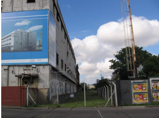
2009 marzo 08. Lateral de la abandonada Bodega Giol sobre la calle paraguay
