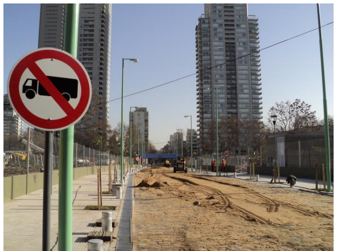
2011 julio 07. Apertura de la calle Soler entre Godoy Cruz y Juan B. Justo. A la derecha, obra del MinCyT / CONICET.
