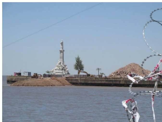
Rellenos sobre el Estuario del Plata. Fotografías del avance de obra tomadas el 15 de noviembre de 2018, dos semanas antes de aprobarse la ley que los autorizaba.
