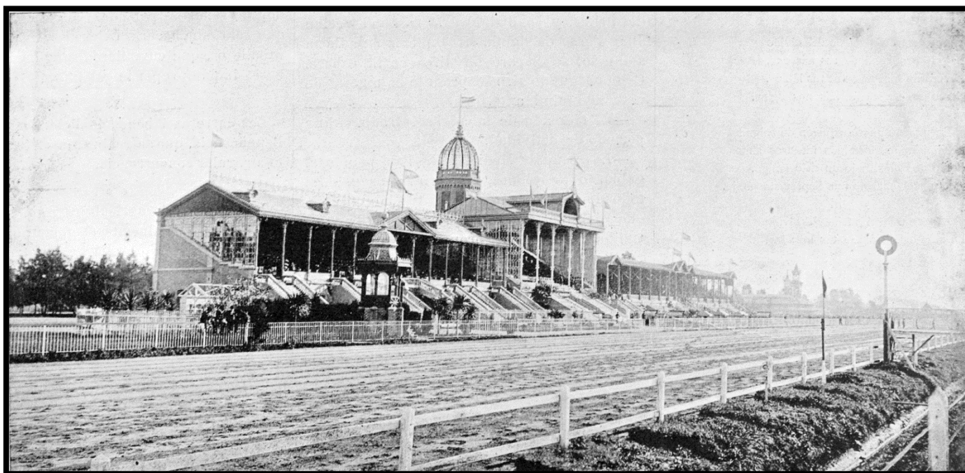
Mayo de 1876. Se inaugura la primera Tribuna Oficial: era de madera, ladrillos y techo de zinc. Tenía capacidad para 1600 personas y 40 palcos para familias (Revue Illustrée du Rio de la Plata).
