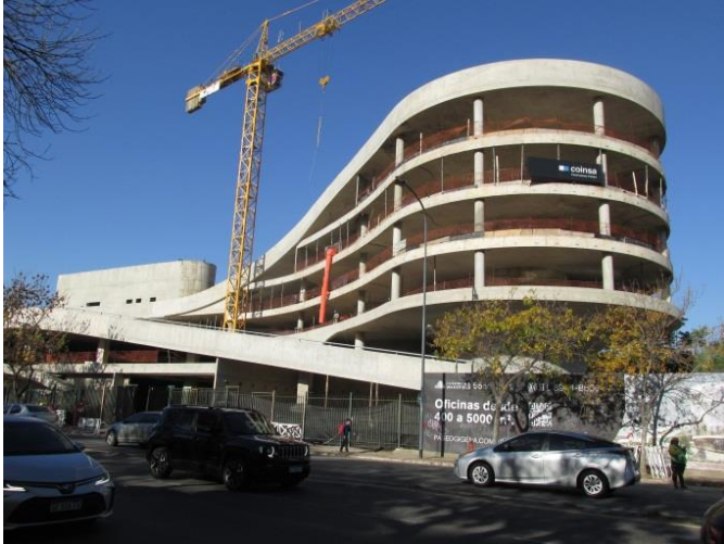
Avance de obra al 8 de mayo de 2023
