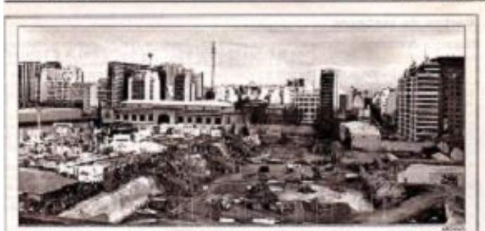
El hueco que dejaron las obras inconclusas en la Rural ha estado reconvertido en zona pùblica de off road
