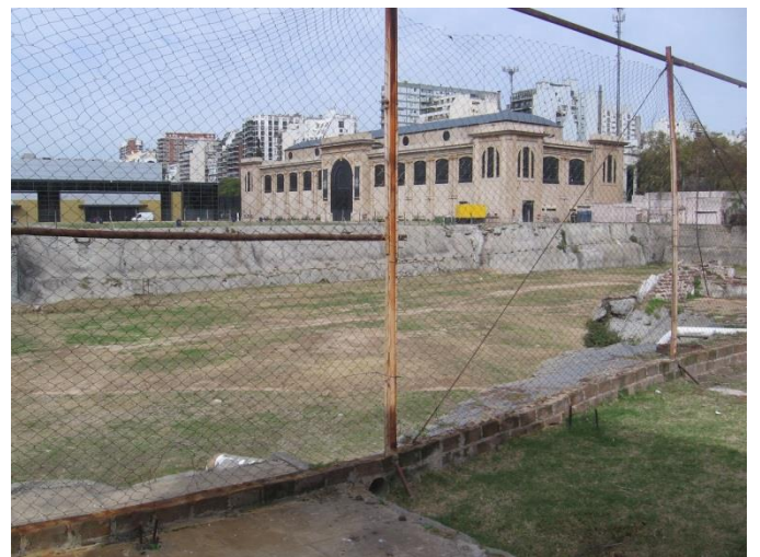
"El pozo" de 15.000 m2 de superficie y 8 m de profundidad donde se hubiera ubicado el estadio para 12.000 personas, con shopping y cocheras para mil vehículos. Arriba, a la derecha, el pabellón Frers
