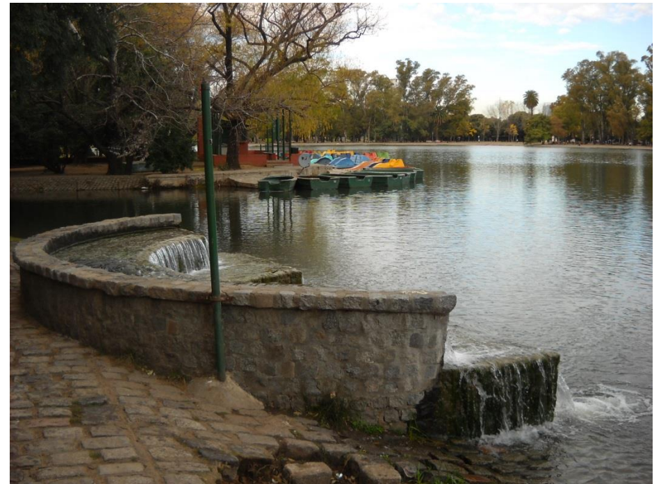
"Cascadita" desde donde se alimenta el Lago de Regatas con agua semitratada proveniente de la planta potabilizadora de AySA. Al fondo, las nuevas (2013) embarcaciones de plástico.
