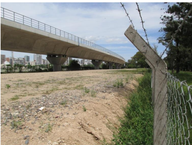
Alambrado olímpico con postes de hormigón y coronado con alambres de púa que protege el sector compactado y elevado paralelo al nuevo viaducto, tomando unos 25 m de la Plaza Pakistán.
