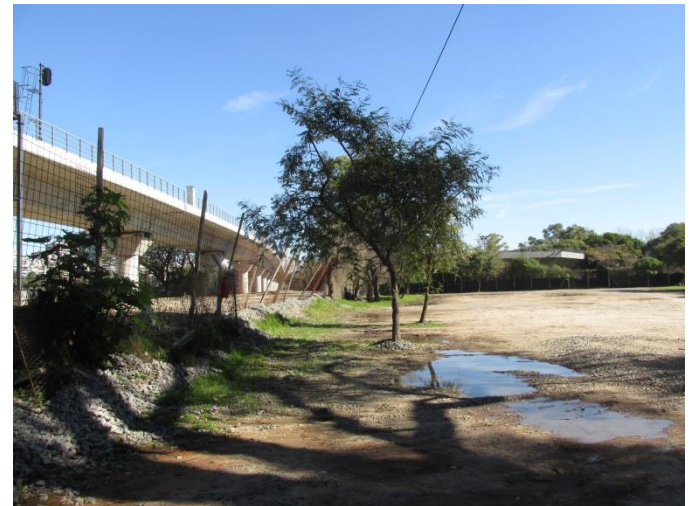
Plaza Pakistán/Parque 3 de Febrero y el viaducto lindante
