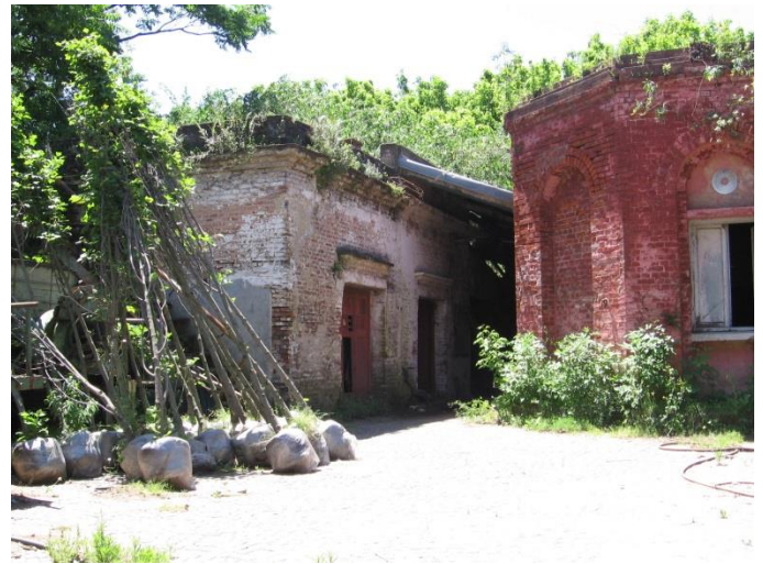
Parte de las construcciones de fines del siglo XIX que forman el conjunto edilicio conocido como "La Boyera".
