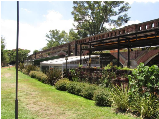
Arcos del viaducto de la Línea San Martín y su entorno, ocupados ilegalmente por locales comerciales.
